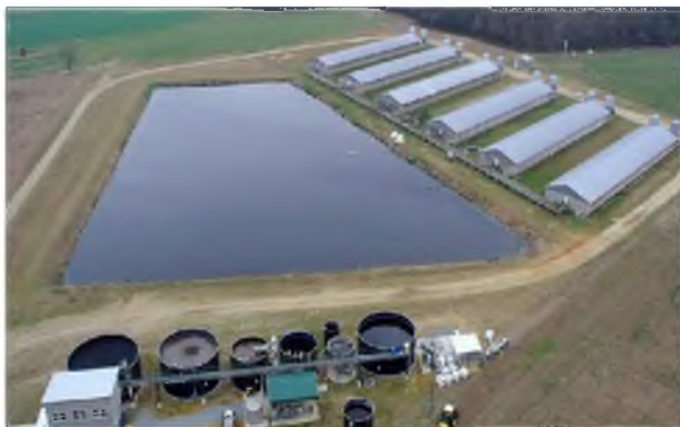
Рисунок 1. Примеры устройства навозохранилища (пометохранилища) по типу «лагуна» (слева заполненная, справа незаполненная).
