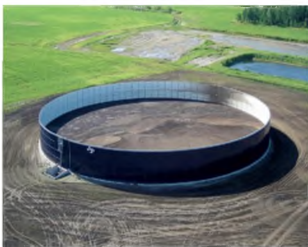
Рисунок 2. Примеры устройства навозохранилища (пометохранилища) по типу «наземный резервуар» (слева открытый, справа закрытый).
