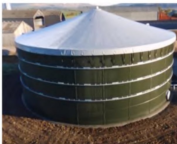
Рисунок 2. Примеры устройства навозохранилища (пометохранилища) по типу «наземный резервуар» (слева открытый, справа закрытый).
