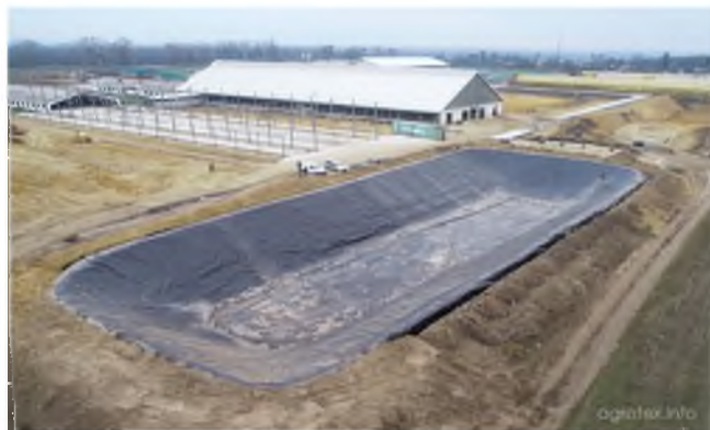
Рисунок 1. Примеры устройства навозохранилища (пометохранилища) по типу «лагуна» (слева заполненная, справа незаполненная).
